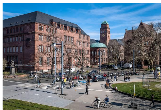
Kollegiengebäude I (KG I)
